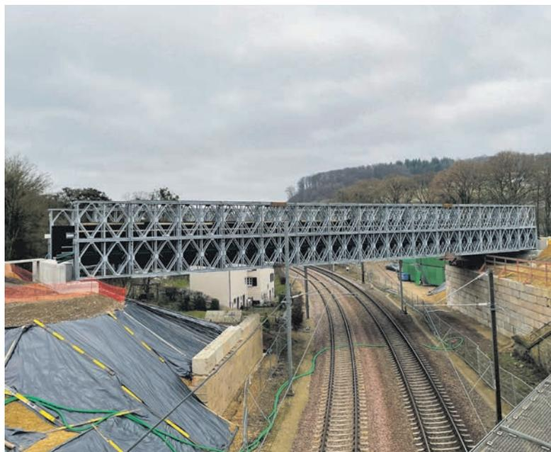
**Behelfsbrücke:** Die Behelfsbrücke über den Schienenweg auf der CFL-Nordstrecke zwischen Schieren und Colmar-Berg wurde am 29. Januar in nur 90 Minuten auf ihren Platz gehievt. Jetzt kann also mit dem Abriss und Neubau der alten Brücke begonnen werden.
