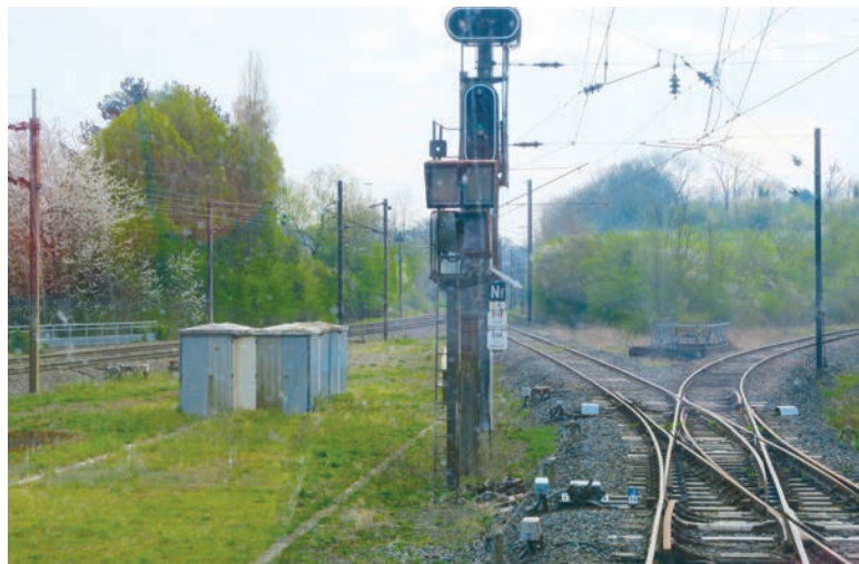
4) Einmal im Jahr geht das Ausfahrtsignal in Richtung Saarland noch auf Fahrt. Die Strecke nach Dillingen biegt nach rechts ab, links geht es nach Creutzwald und Forbach. Am Signal erkennt man die Tafeln für die betrieblichen Bestimmungen der jeweiligen Strecken: BAPR (Bloc automatique à permissivité restreinte) vers Creutzwald, BM (Bloc manuel) vers Hemmersorf.
