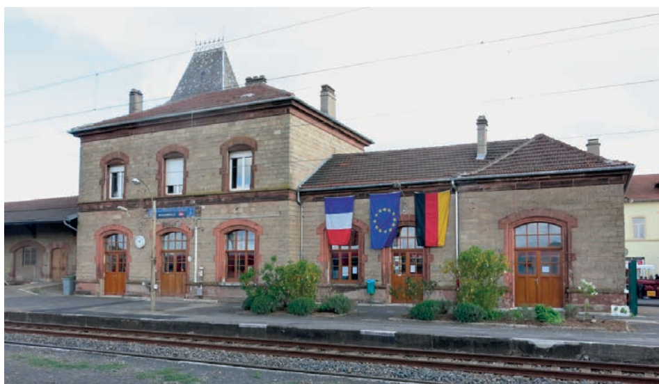
Foto: Bahnhof Bouzonville
