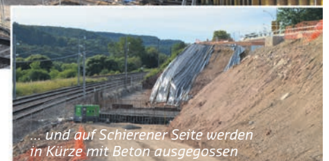
Die Verschaltungen für die Brückenaufleger auf der Seite von ColmarBerg
