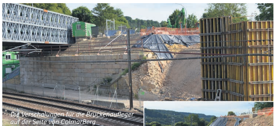
... und auf Schiererener Seite werden in Kürze mit Beton ausgegossen
