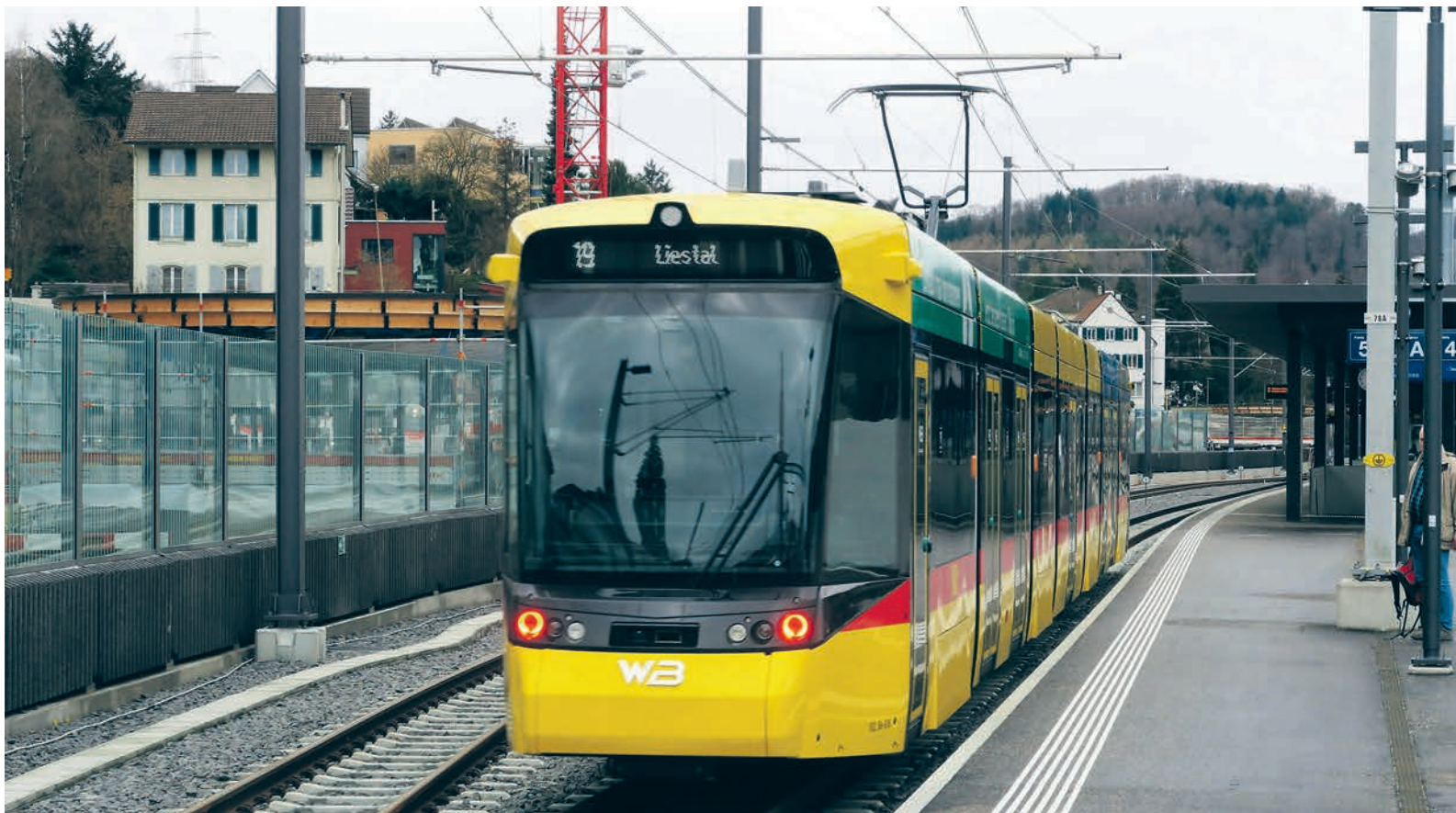
Einfahrt in den neuen Bahnhofsteil der Waldenburger Bahn in Liestal
