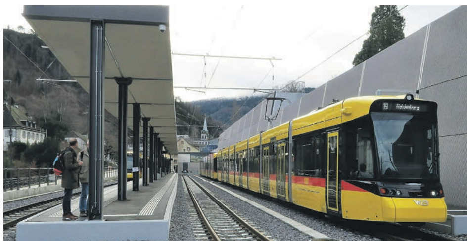
Der neue Bahnhof von Waldenburg. Rechts im Bild die neue Werkstatt.
