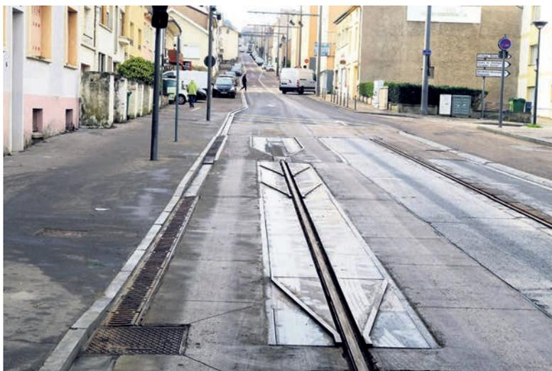
Die Einfädelungseinrichtung in die Führungsschiene an der Haltestelle Callot.
