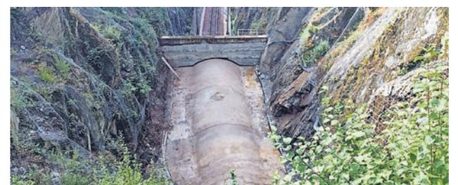
Geröllschuttkammern (Sicht von oben), wie diese bei Bürden, sollen Gleise und Züge vor herunterfallenden Steinen schützen
