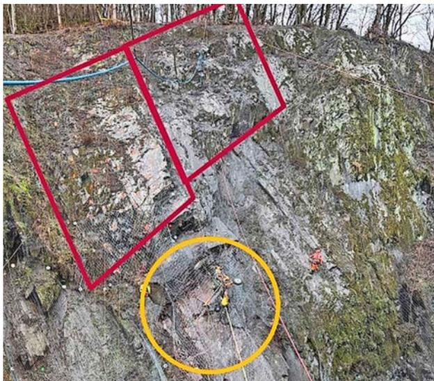
Die Felswand bei Bürden soll mittels passiver Verankerungen und diverser Netze (in Rot) gesichert werden. Brocken innerhalb des gelben Kreises haben sich am Wochenende gelöst. Fotos: CFL
