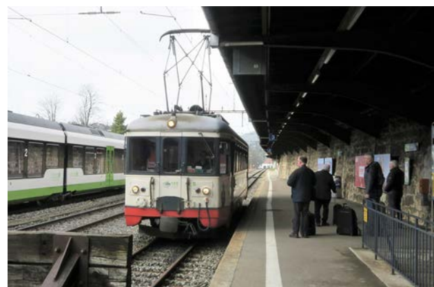
7) In Le Locle besteht die Infrastrukturanlage der Bahn nach Les Brenets nur aus einem Stumpfgleis.
