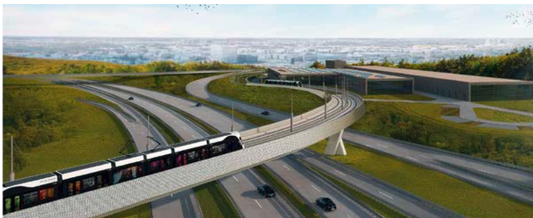
Das Prunkstück dieses Abschnitts ist sicherlich die neue 110 m lange und 10 m breite gebogene Brücke über die Autobahn A1.
