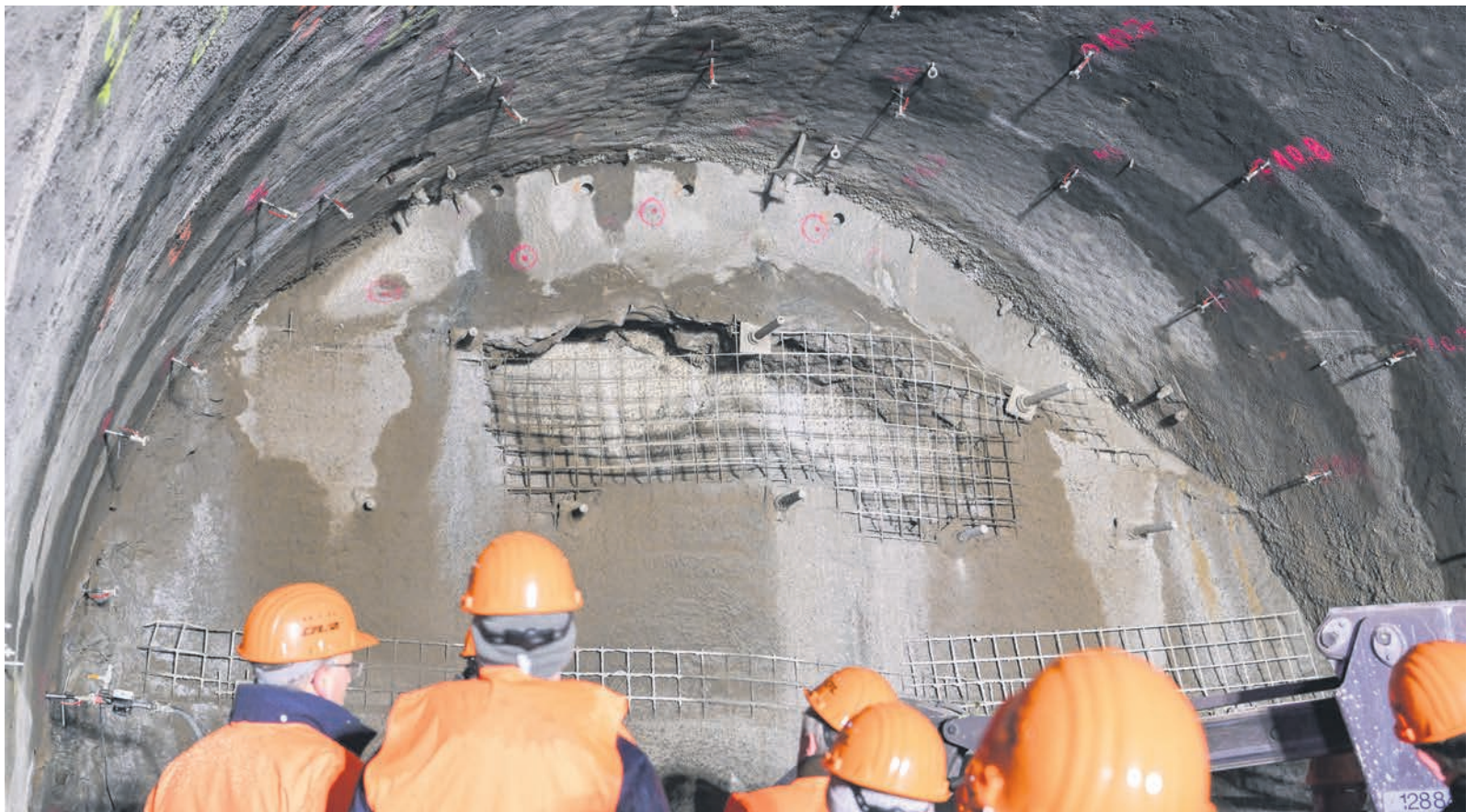
414 m 3 Beton wurden zur Stabilisierung des Schieburg-Tunnels in den Fels injiziert
