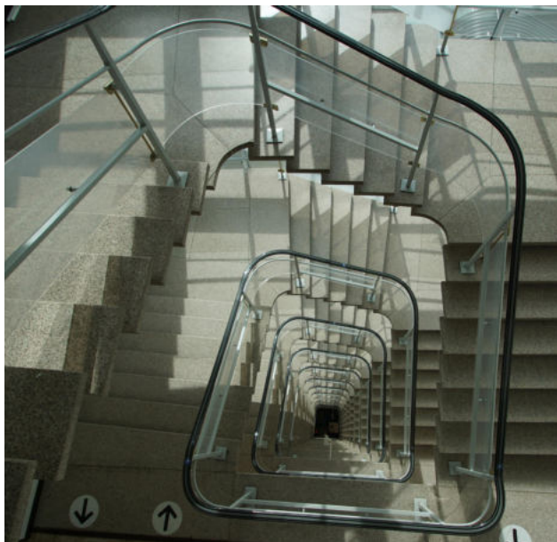
Treppenhaus von oben betrachtet
